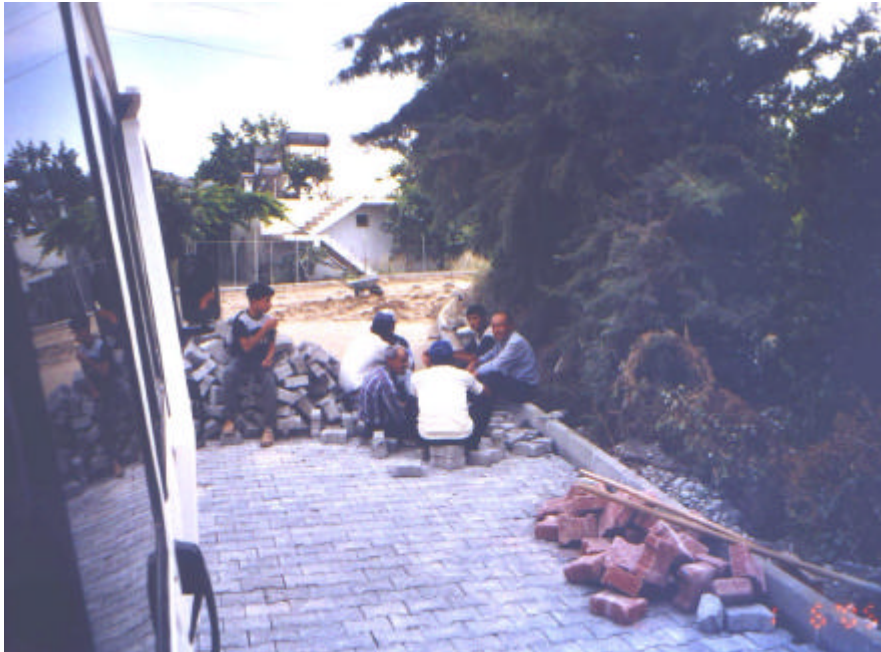
Wenn türkische Straßenbauarbeiter vespern, wird der Verkehr einfach stillgelegt.
